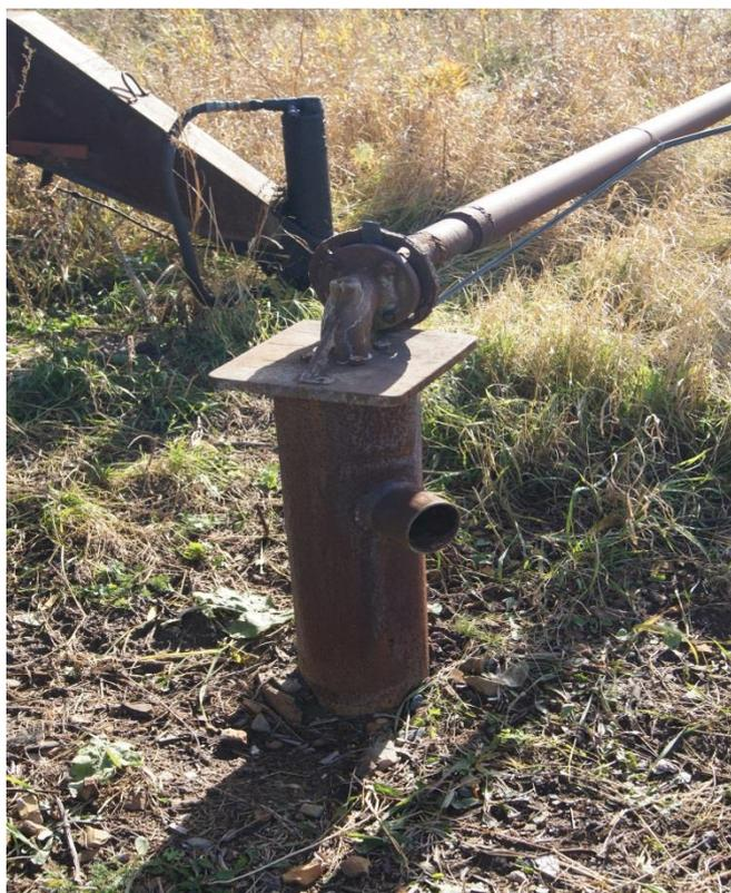
Рисунок 2.2 – Оголовок рабочей скважины системы централизованного водоснабжения п. Троицкий
